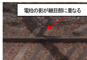
図-1 継目部抽出漏れ例
