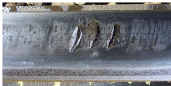
図1 中きしみ割れの外観
