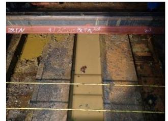
写真-2 防振箱内滞水状況
