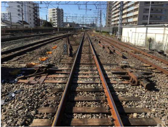
図3 分役レール撤去棒線化の対象分岐器 (施工後)
