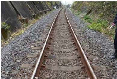
図 1 試験現場の写真
