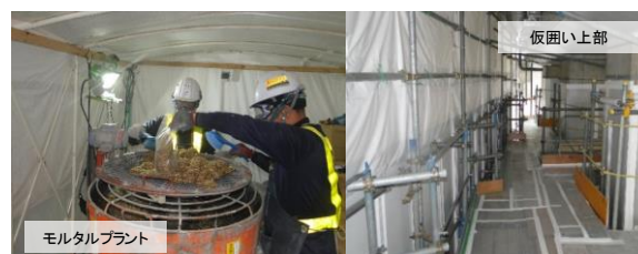
写真2 飛散養生状況
