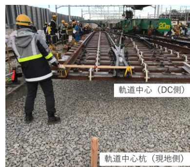
図-7 DC部据え付け確認
