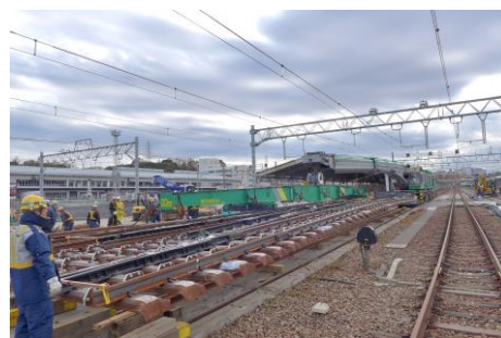
図-4 鉄道クレーン車施工状況
