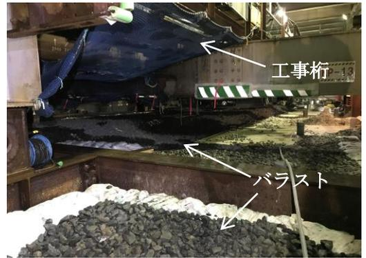
写真-1 工事桁直下のバラスト事前搬入状況
