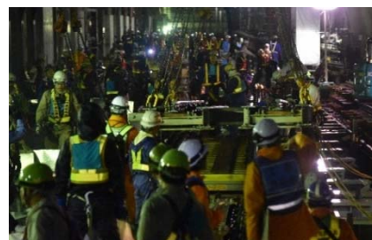
写真-2 工事桁撤去状況
