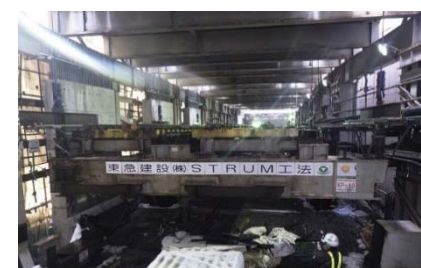
写真-3 工事桁扛上 (STRUM 工法)
