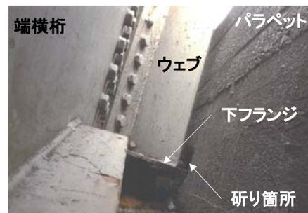
写真-1 パラペット接触箇所
