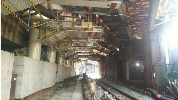
写真-1 桁受替工事後写真
