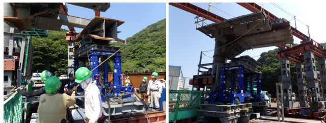
写真-3 デモンストレーション施工
