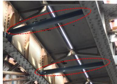
図-7 水平変位抑制対策
