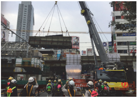
写真-2 既設桁の撤去状況
