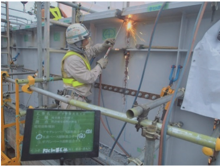
写真-1 既設桁の切断試験
