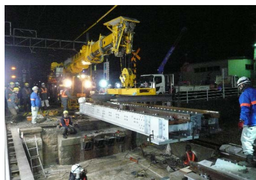
写真-3 軌陸クレーンによる新桁架設
