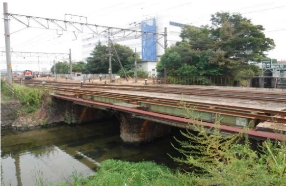
写真-1 阿瀬知川橋りょう全景
