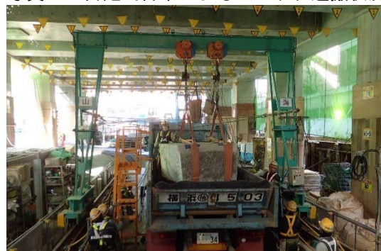
写真-4 ブロック積込状況
