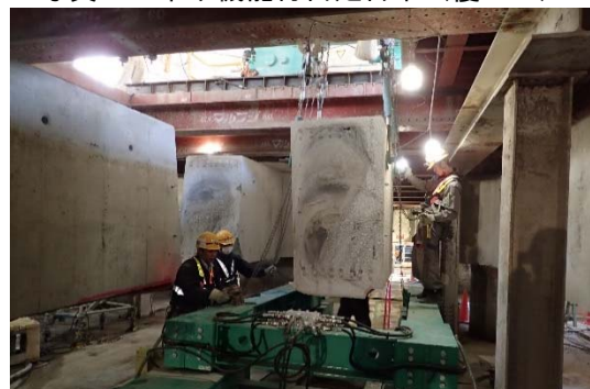
写真-2 ブロック積載状況
