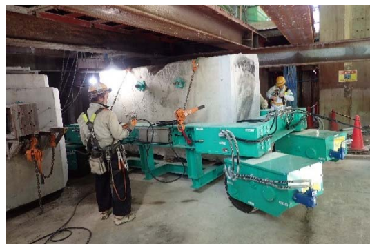
写真-3 自走式台車によるブロック運搬状況
