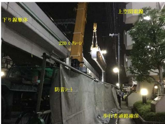
写真-2 側道でのクレーン架設状況
