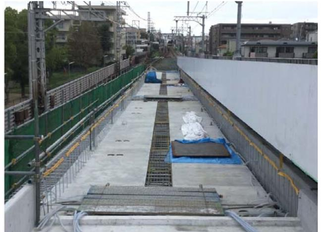
写真-5 連続 Pc 桁架設完了
