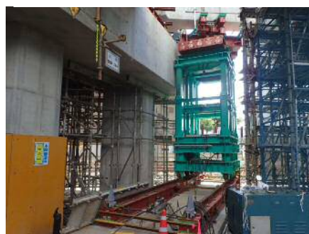
写真-4 押上ジャッキ組込式 横取り装置
