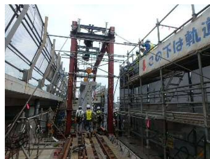
写真-3 セグメント揚重状況
