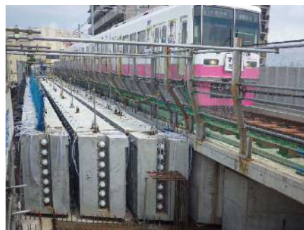
写真-5 PC 桁架設完了
