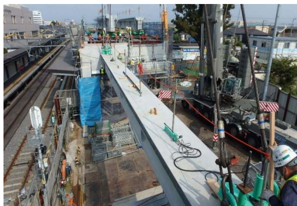
写真-2 クレーンによる直接架設（1期工事）
