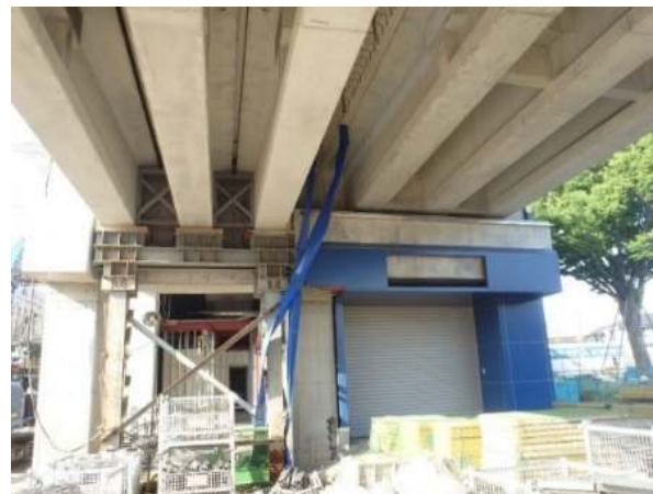
写真-3 PC桁の仮置き状況
