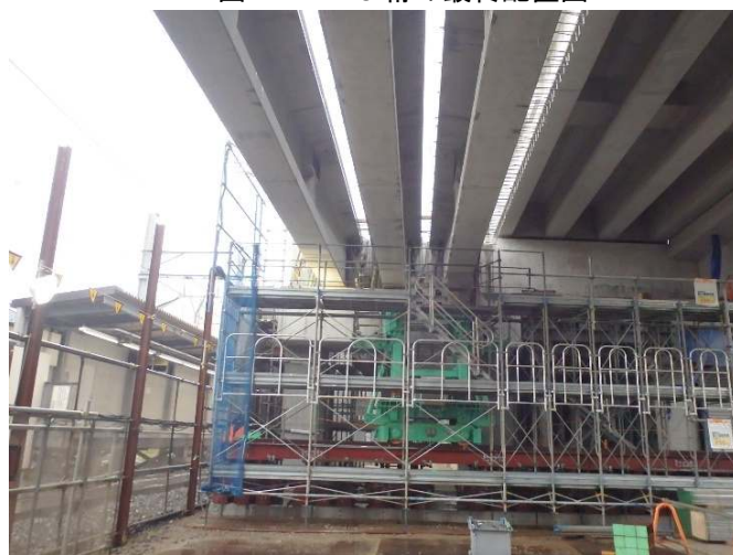
写真-1 PC 桁の横移動状況
