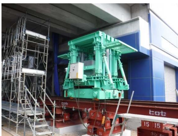
写真-4 横取り装置および架台
