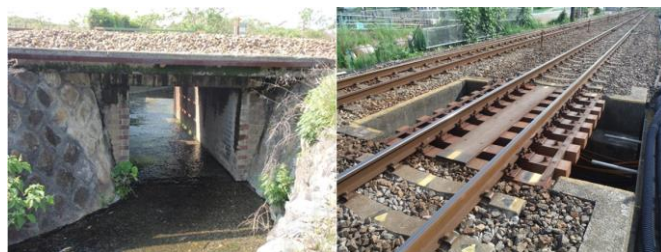
図 2 既設橋りょう（左：下り線、右：上り線）
