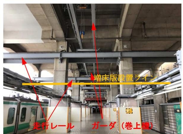
写真-1 クレーン設置状況
