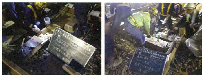
写真-1, 写真-2 継手まくらぎ接合施工状況
