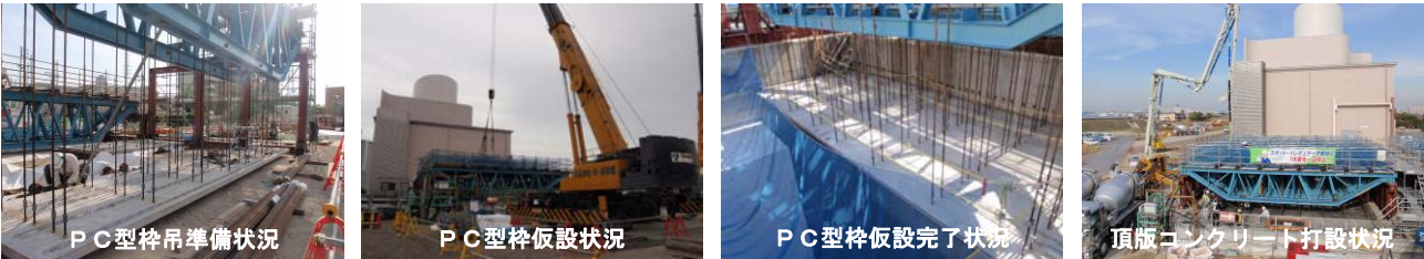
写真-1 主要工種施工状況写真
