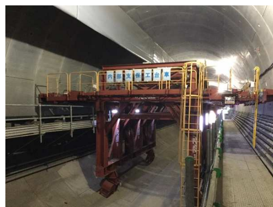
写真-2 内部支保工台車
