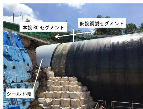
写真-2 発進状況
