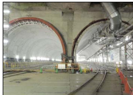
写真-1 併設施工完了状況
