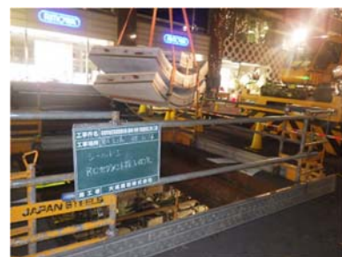
写真-1 セグメント投入状況（夜間道路規制）
