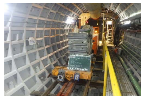
写真-4 ラックアンドピニオン軌道
