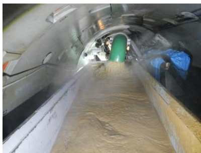
写真-3. 配管による土砂圧送
