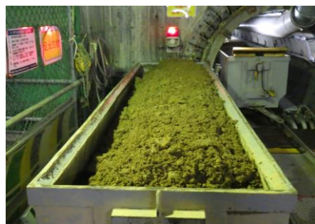
写真-5. 排土の性状（SP-H 使用）
