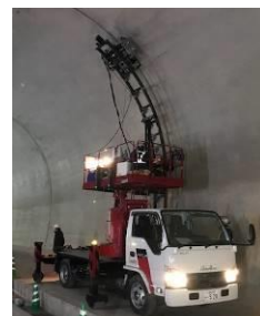
写真-5 Step4 点検実施状況
