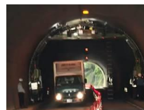
写真-4 Step3 点検実施状況
