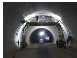
写真-2 Step1 点検実施状況
