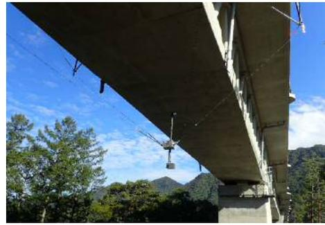
図5 ロボット設置・点検状況
