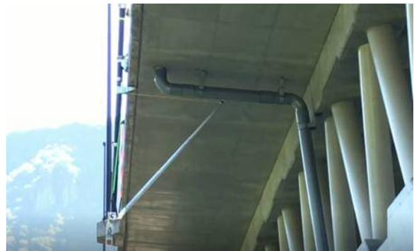
図 2 斜材支持構造による床版への取り付け状況
