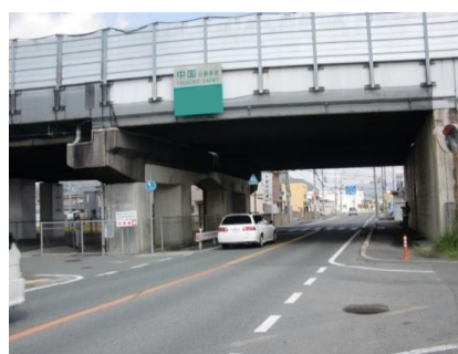
写真 2.1 PC 桁橋の外観
