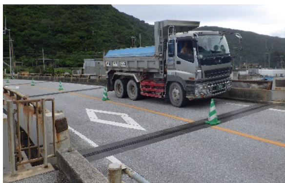
写真-4 載荷試験状況
