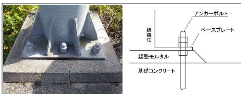
図-1 標識基礎部の構造
