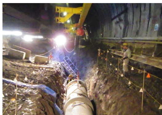
図-3 専用クレーンによるヒューム管の敷設
