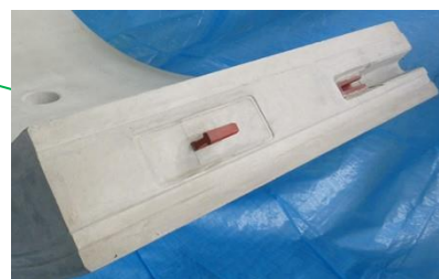
図-2：くさび継手
