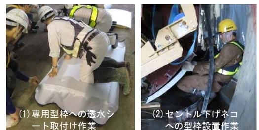
写真-3 透水シートの設置手順
