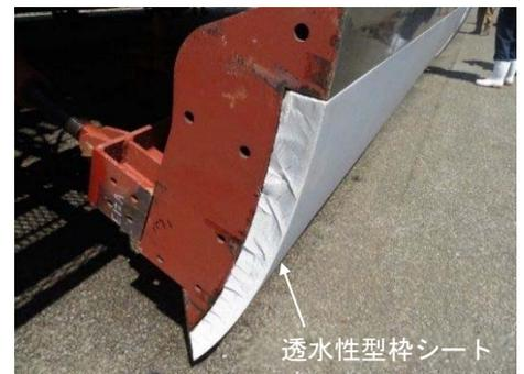
写真-1 透水性型枠シートの設置状況
