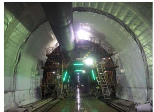
写真3 高排水シート施工完了
