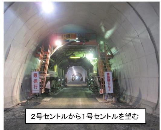
写真-1 覆工コンクリート打設状況
