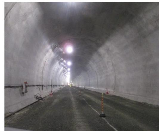
写真-2 覆工コンクリート仕上り状況
