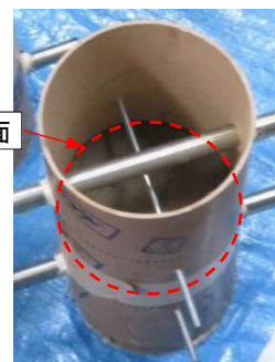
写真－4 2層目打設
