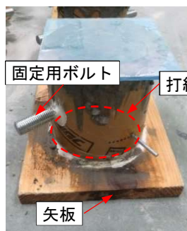
写真－3 1層目打設
