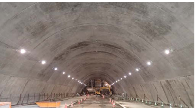
写真-6 施工完了全景
