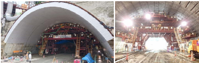
写真-3 覆工施工時の状況
