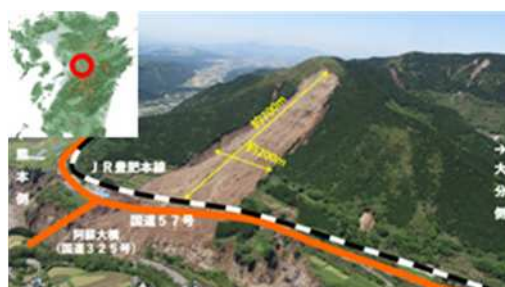
写真-1 現場全景写真
