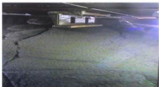
写真-2 作業室内部のモルタル打設状況
