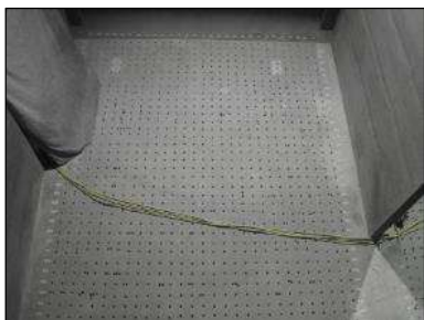
写真-1 底版部削孔状況
