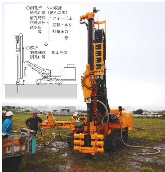
図-1 削孔検層実施状況
