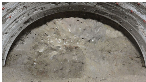
図-4 DIIパターンの切羽写真例
