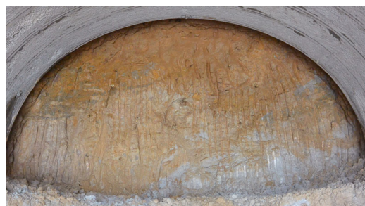
図-3 DIIIパターンの切羽写真例
