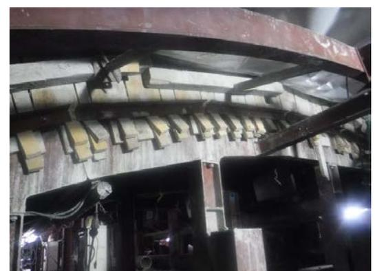
写真-4 妻型枠の設置状況
