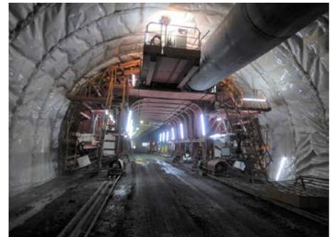
写真-1 トンネル坑内セントル
