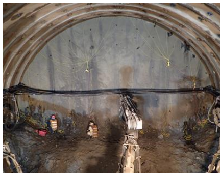
写真-4 落石防護ネット設置状況
