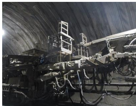
写真-3 ガードプロテクター設置状況
