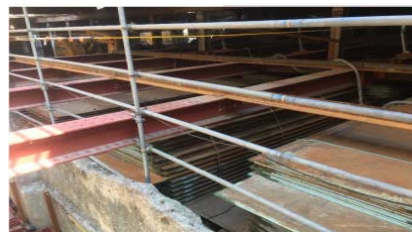
写真-1 敷鉄板設置状況
