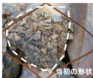
図-4 中詰め用栗石の風化による細片化
